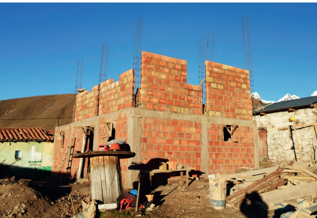
Das Medical Center während dem Bau
